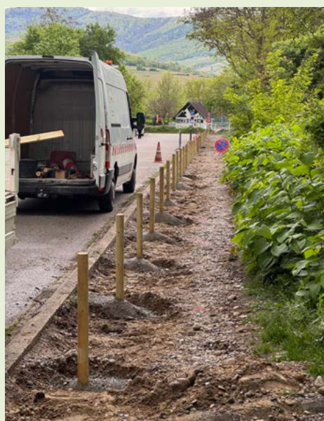
Pose d'une rambarde de sécurité pour les piétons, secteur des étangs
