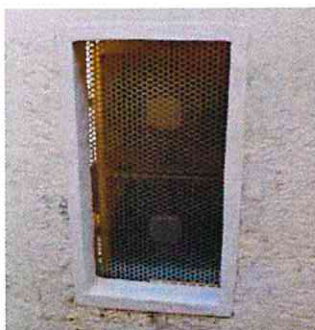
Exemple de traitement pour les échangeurs de climatiseurs ou de pompes à chaleur.
