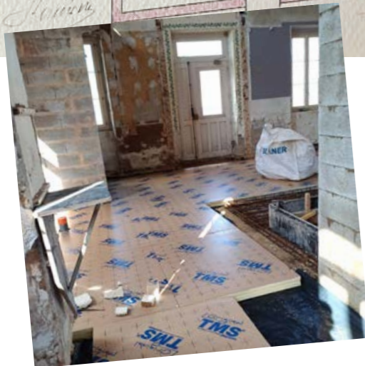
L'isolation du sol avant le coulage de la chape a commencé.
