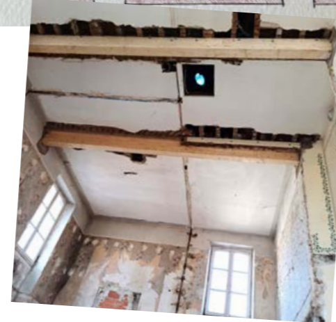
Un renforcement de la charpente avec des poutres lamellées collées a été nécessaire.
