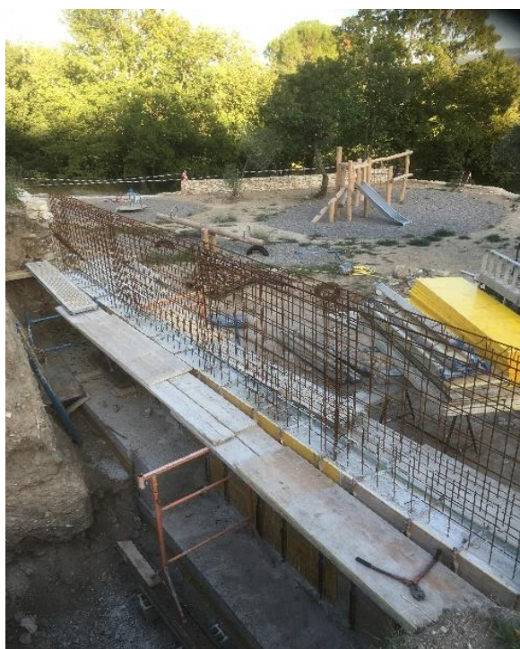
Mur en béton banché
