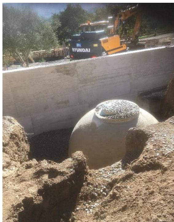
Pose du silo
