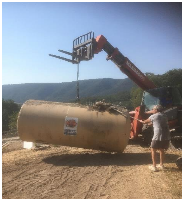
Extraction de la cuve fioul
