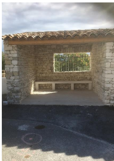
Abri bus côté route
