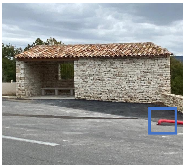
Abri bus côté route et futur emplacement de la borne de recharge encadré en bleu
