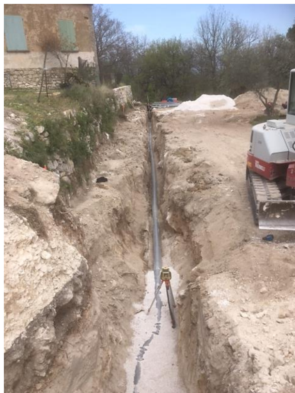
Rénovation complète du linéaire d'assainissement collectif, maintenant couvert par les magnifiques gradins en pierre
