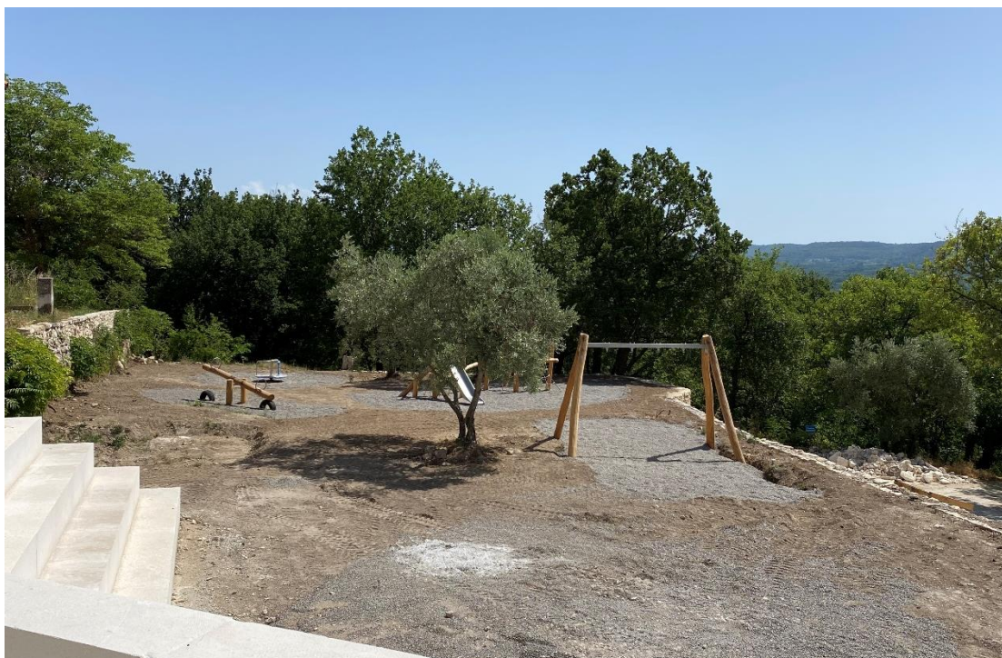
La création de notre aire de jeux pour enfants commence à prendre tournure, restent à traiter tous les abords en ferronnerie, les arbres et haies ainsi que les finitions
