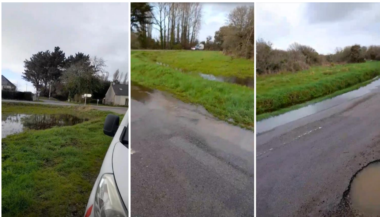
Figure 30 : Débordement de la zone humide - Observation lors du récolement du réseau (04/03/2024, à 16h50 – Photos Labocéa)
