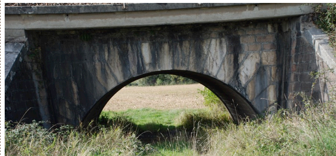
Traversée de la voie ferrée au niveau du corridor n°5.
