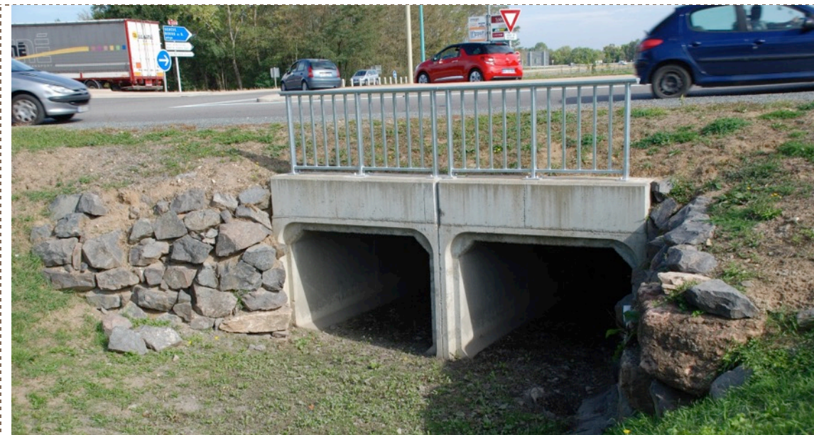
Traversée de la RD906 au niveau du corridor n°5
