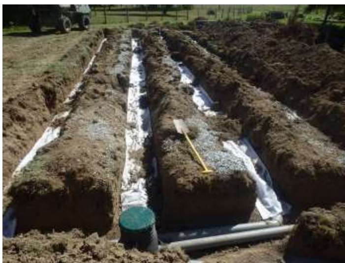
Assainissement non collectif composé d'un traitement de type tranchées d'épandage
