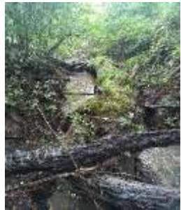
St Firmin-sur-Loire, avant travaux
