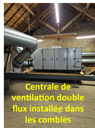
Gaines de ventilation dans les combles
