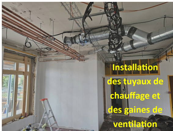
Gaines de ventilation dans les combles
