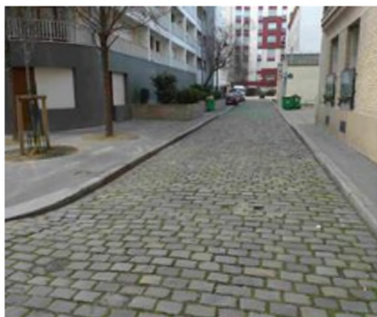
PASSAGE MONTBRUN : PAVÉS À JOINTS ENGAGONNÉS.
