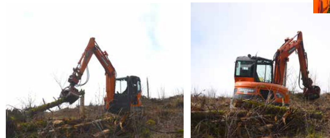
Préparation du sol par l'entreprise TP Warrior (Eddy Baumgart)
