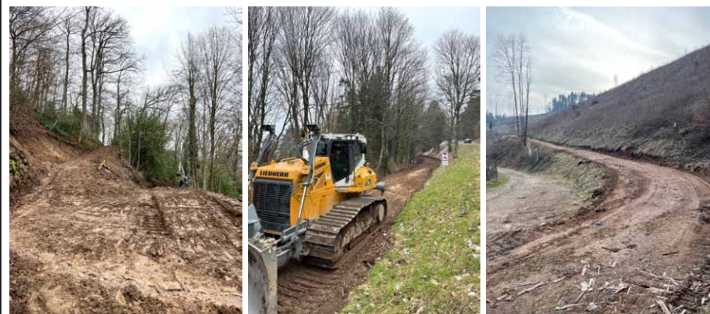
Travaux exécutés par l'entreprise TP Warrior (Eddy Baumgart)
