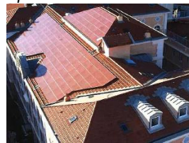
↑ Autorisé : Panneaux en surimposition, teinte avoisinante à celle des tuiles
