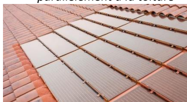
↑ Autorisé : Panneaux intégrés, teinte avoisinante à celle des tuiles
