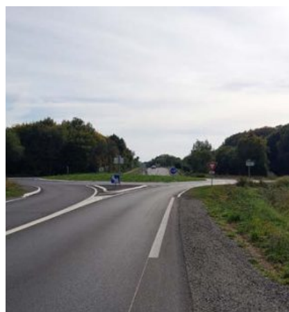
Le giratoire est placé sur la commune de Plesder.
