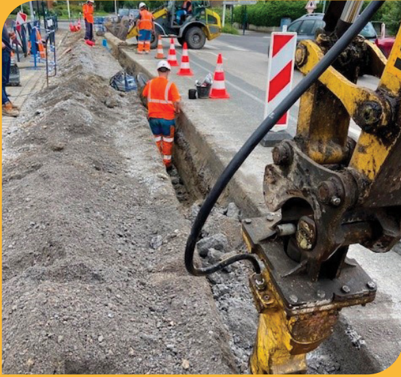
Nouveau réseau à proximité de la conduite en diamètre 500
