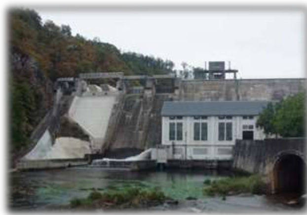
Photo 37 : Barrage hydroélectrique de Saint-Marc
