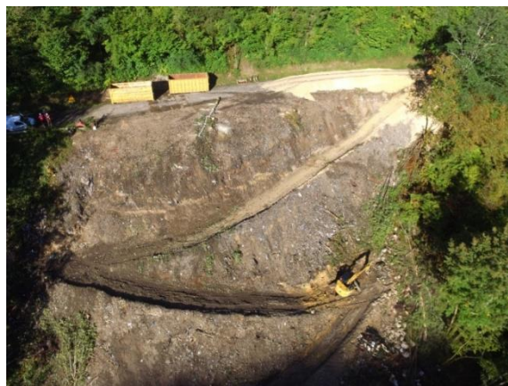
chantier de nettoyage de la décharge du Longviry ©PNRHJ/R.Bellier
