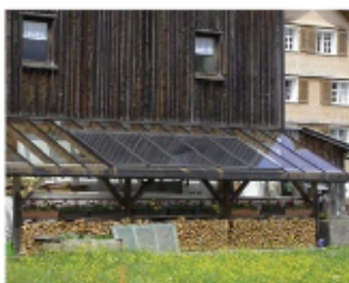
Les capteurs sont intégrés à la couverture d'une remise à bois. Maison individuelle (Vorarlberg, Autriche) © PNR du Vain français
