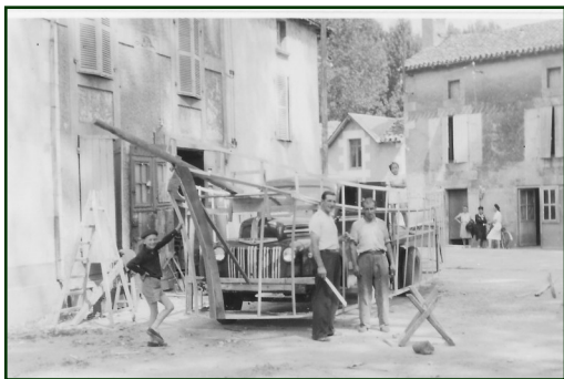
Construction de l'armature devant la boutique de Eugène GUILLAUD sur le plan de l'église de Saint-Maurice.
