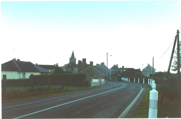
La voie s'appuie sur la topographie et son implantation offre un point de vue sur la Mairie
