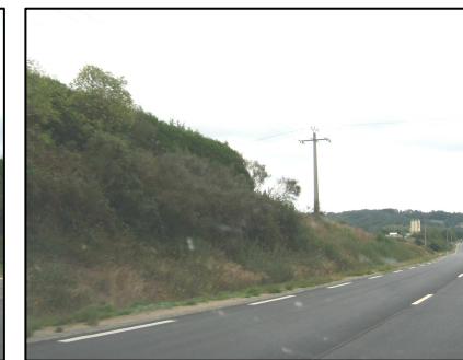
La RD 178 est encaissée par rapport au terrain naturel. Le talus planté limite l'impact visuel et sonore
