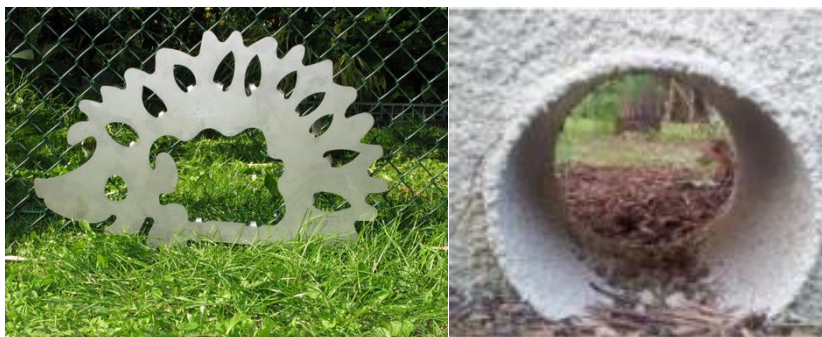
Figure 1 : Exemples d'ouvertures dans un grillage et un muret, prévues pour le passage de la petite faune
