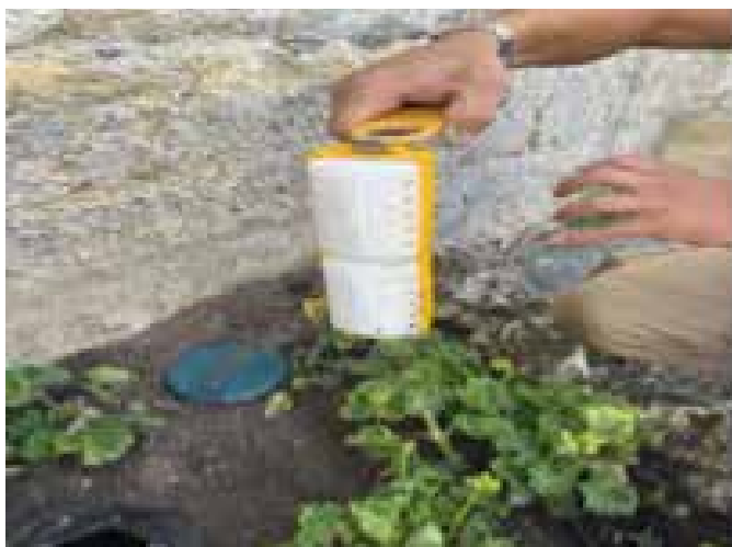
ALLO-TERMITE dépose les 32 pièges en périphérie de l'église
