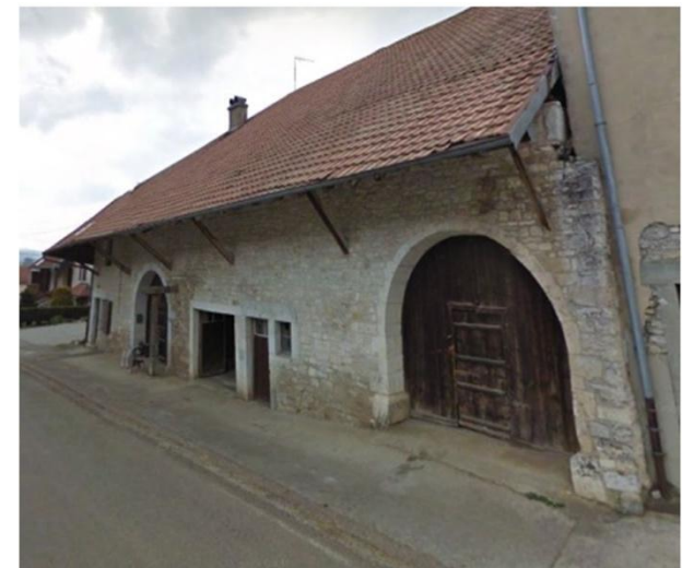
Exemple de débord de toiture soutenu par des consoles à Longeville (source : Urbicand)
