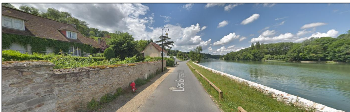
Figure 54 : Photographie depuis les Berges de Seine (Source : Google Street View)
