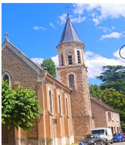
Figure 57: Paroisse de Saintry-sur-Seine
