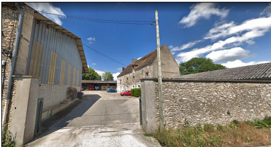
Figure 44 : Ferme historique dans le hameau de Montceaux (Source : Google Street View)
