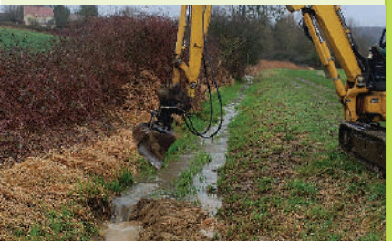
Création d'un chenal pour favoriser les écoulements à Crisolles (60).
