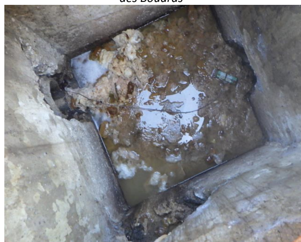
Dépôts, Stagnation d'effluents – Regard n° 21034 – Réseau EU – Rue des 4 Vents
