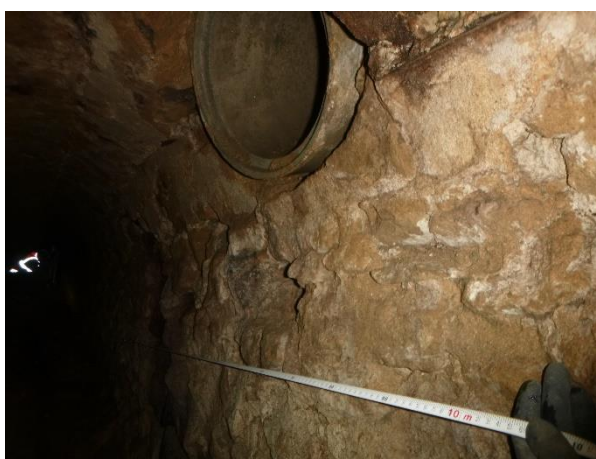
Conduite n°5 - 400 Béton
