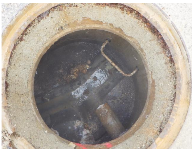
Dépôts– Regard n° 21043 – Réseau unitaire – Le Village
