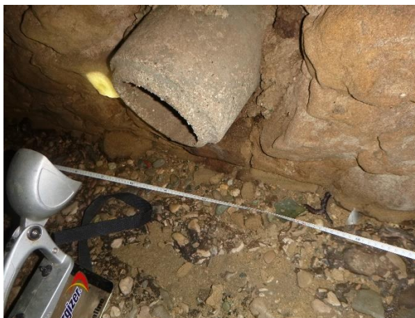
Conduite n°4 - 100 Béton
