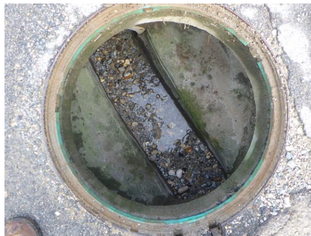
Dépôts –Regard n° 29685 – Réseau unitaire – Chemin des Boudras
