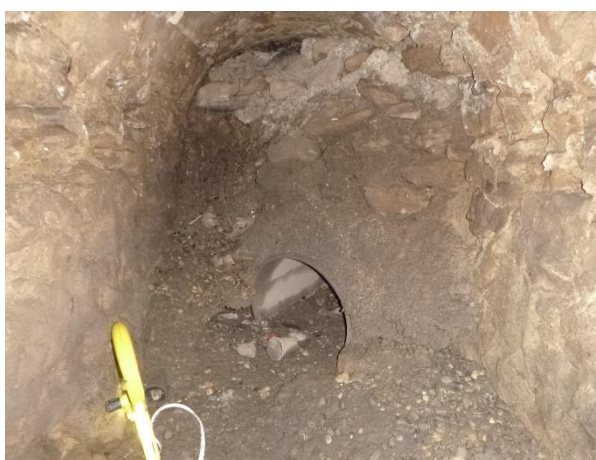
Conduite n°6 - 400 PVC en sortie
