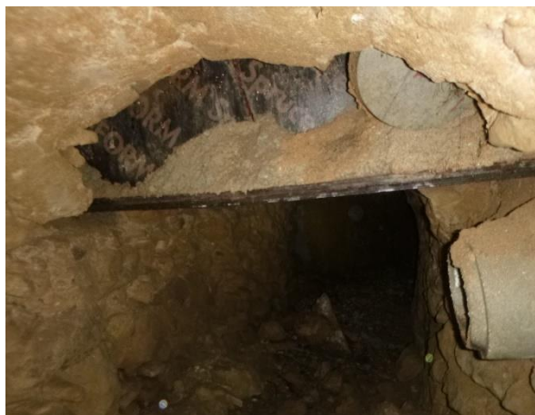
Conduite n°3 - 100 Béton
