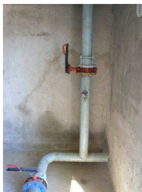
Figure 16 : Chambre des vannes - Conduite d'adduction
