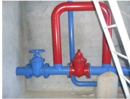
Figure 28 : Conduite de refoulement et conduite de distribution avec défense incendie
