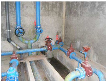
Figure 11 : Chambre des vannes
