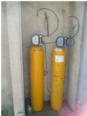
Figure 6 : Bouteilles de chlore
