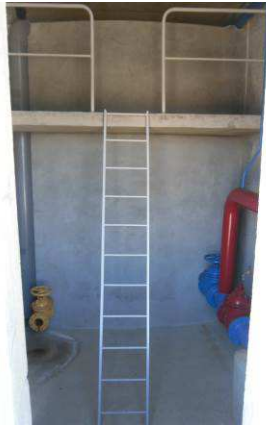
Figure 27 : Chambre des vannes - vue globale
