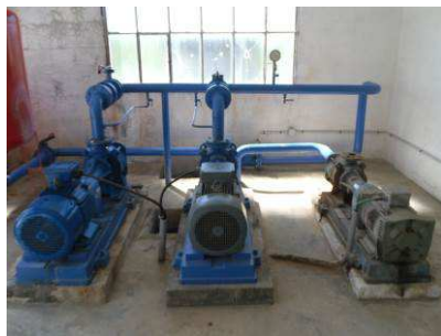
Figure 32 : Pompes de surface
