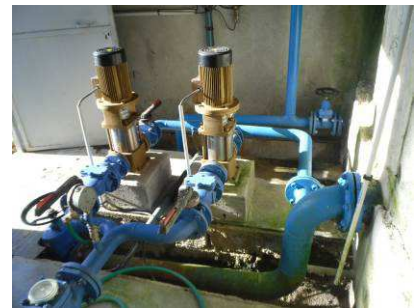
Figure 26 : Bâche de reprise - chambre des vannes
