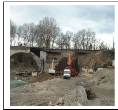
En amont de Ners, réparation du pont de la voie ferrée partiellement emporté (photo BCEOM)
