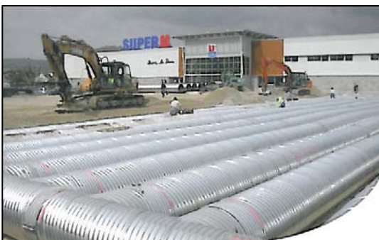
► Rétention EP visitable sous voirie SPIREL®- TURBISIDER
