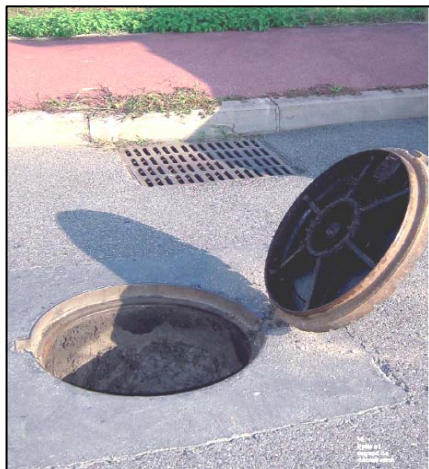
► Puits d'infiltration sur voirie (à éviter)
