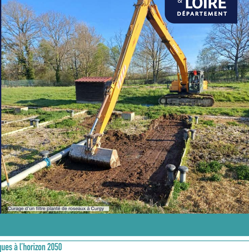
Curage d'un filtre planté de roseaux à Curyg
