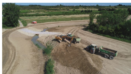
Travaux Briançon Théziers
