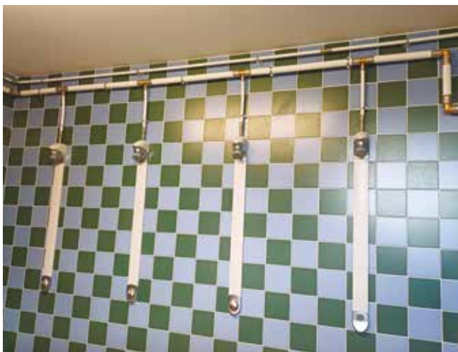
Réalisation de la plomberie dans les vestiaires et les douches
