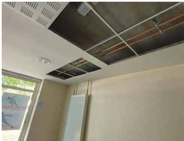
Installation et raccordement de 34 radiateurs neufs
