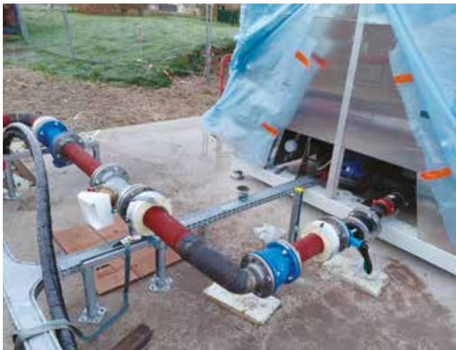
Dalle béton extérieure avec pompe à chaleur
