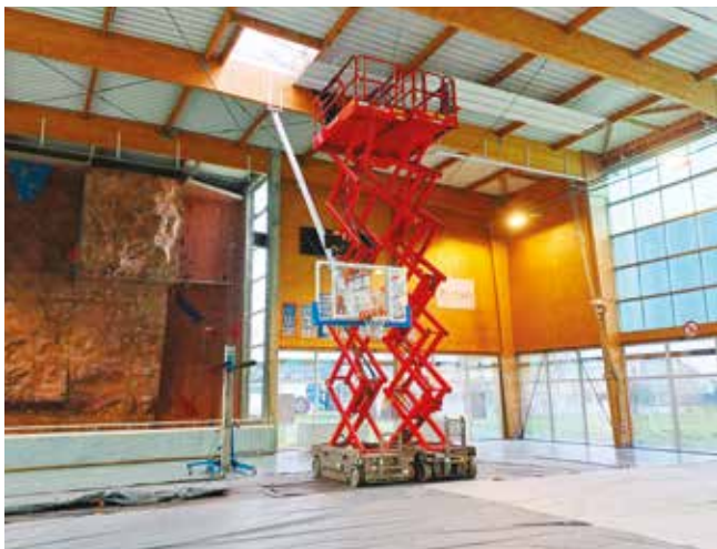
350 m linéaires de panneaux rayonnants réinstallés et raccordés dans les 3 grandes salles
