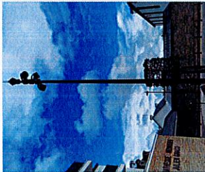
Horloge connectée sur le candélabre qui permet de programmer et contrôler l'éclairage public des communes équipées.
