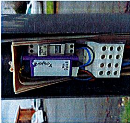
Horloge connectée sur le candélabre qui permet de programmer et contrôler l'éclairage public des communes équipées.
