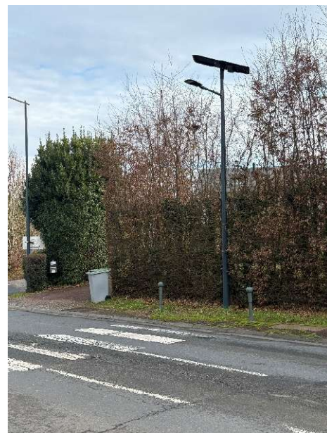
ECLAIRAGE PASSAGE PIETON candélabre solaire
