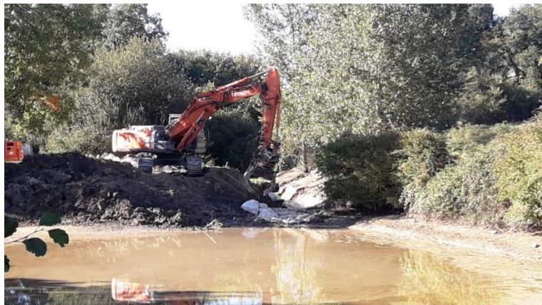
Reconnexion du lit du cours d'eau ©SYGESAVE
