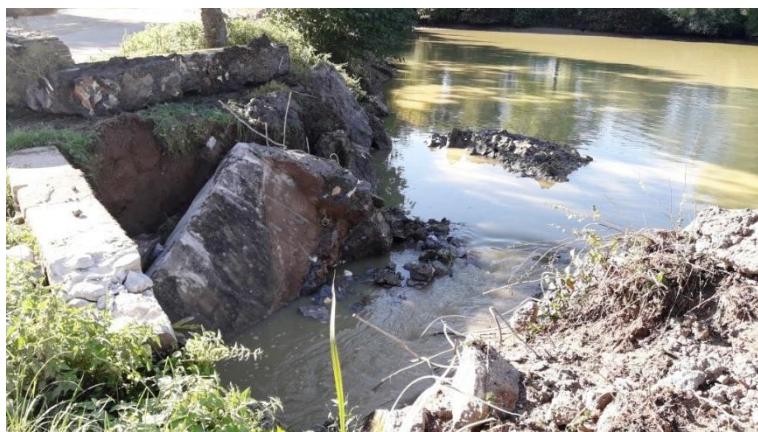
Destruction du déversoir de l'étang ©SYGESAVE
