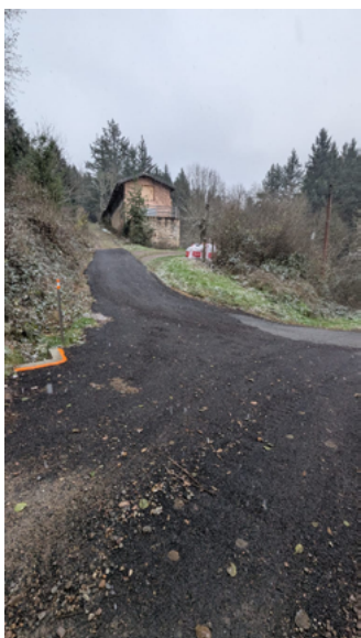
- Chemin de Concize : création de fossés avec évacuation, et réalisation de 30 mètres de goudron à froid (travaux effectués par les employés et plusieurs membres du conseil)
