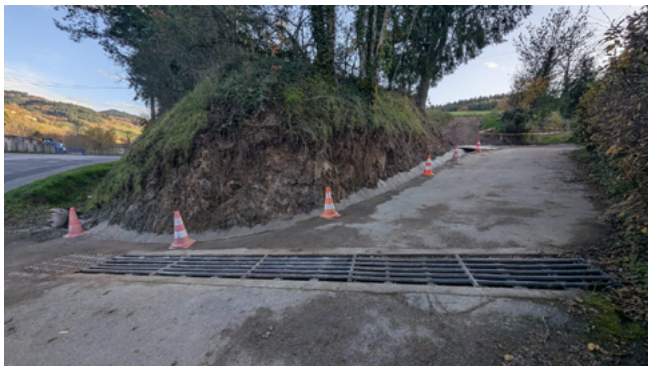
- Chemin Allée des Grands Arbres – Chavannes : mise en place d'un caniveau ; travaux effectués bénévolement par Dominique MARTINS. Matériaux à la charge de la commune : 666 €
