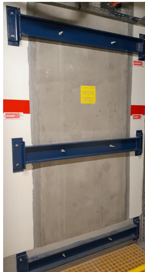
Renforcement des cloisons
