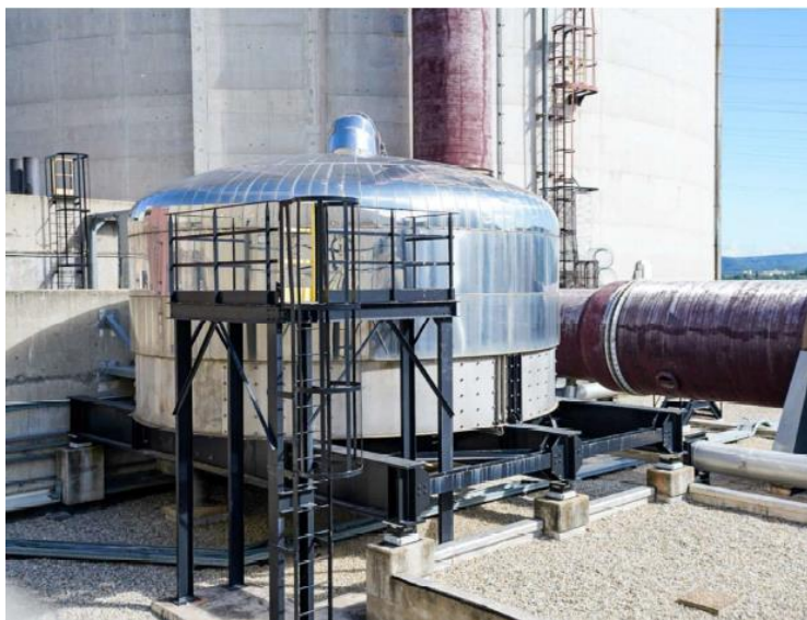
Dispositif U5 d'éventage de l'enceinte
