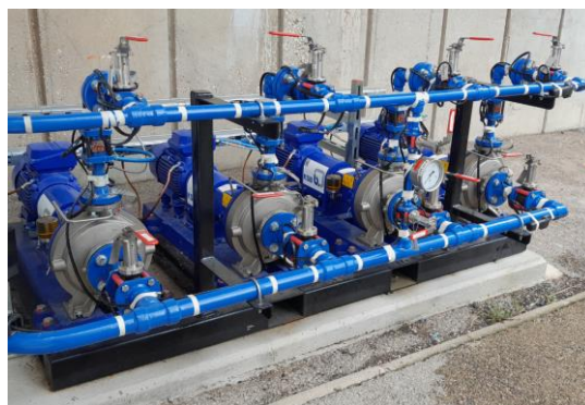
Pompes de surpression du système de brumisation
