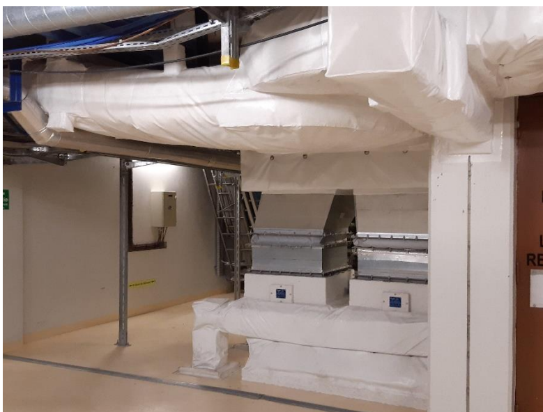
Exemple de protection de chemin de câble
