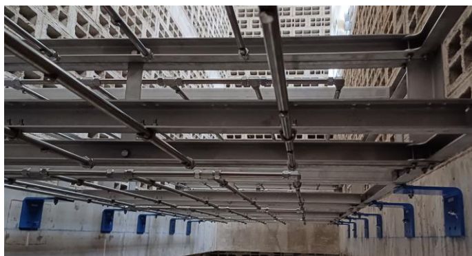
Rampes d'aspersion du système de brumisation
