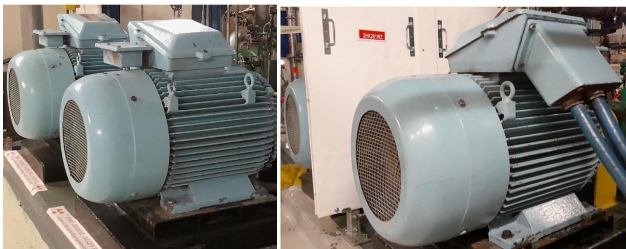
Installation d'un écran thermique entre les pompes du système de refroidissement de la piscine d'entreposage combustible (avant / après)
