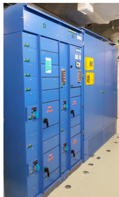
Nouveau transformateur 6,6 kV / 380 V pour l'alimentation du noyau dur
