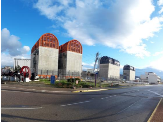
Diesels d'Ultime Secours (DUS) de 3 MWe
