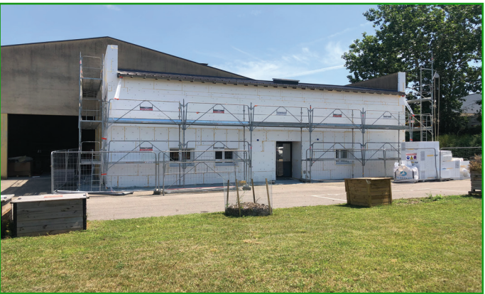
Travaux d'isolation par l'extérieur des bâtiments du Smidom
