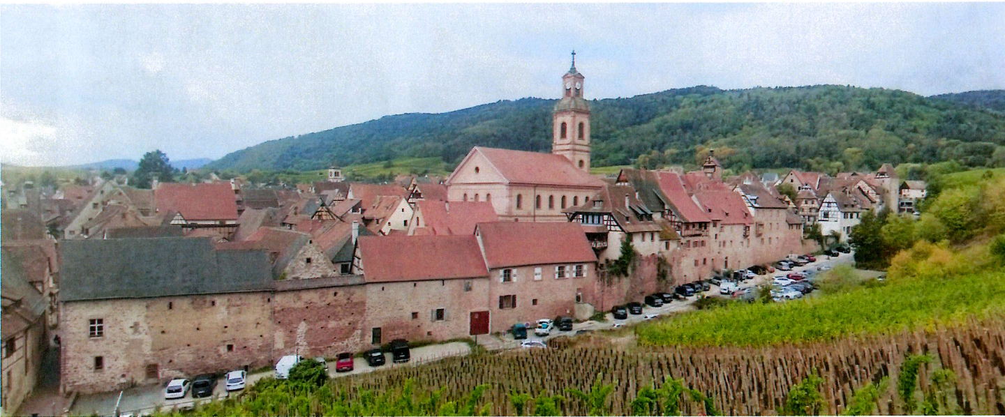
Front nord de l'enceinte, 1291, modifications au XVI e siècle [Source : LMDP, 2024]
