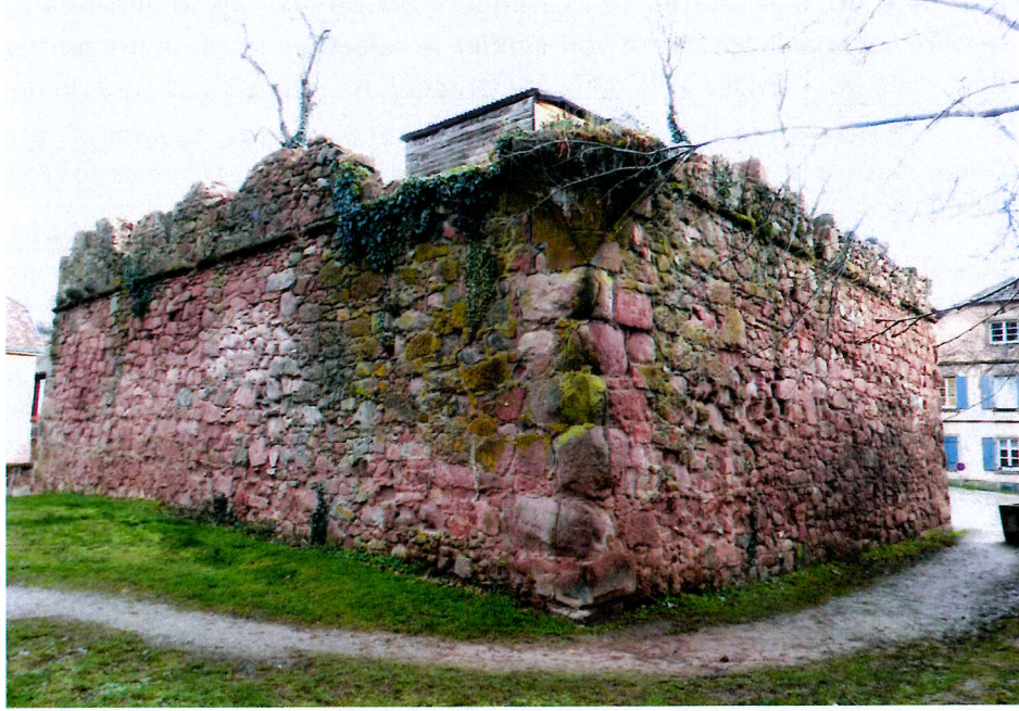
Bastion dans l'angle sud-ouest de l'enceinte extérieure, 1615 [Source : LMDP, 2024]
