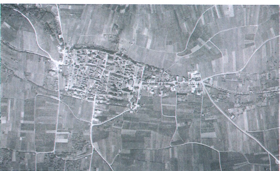
Vue aérienne en 1934 [Source : IGNF, Remonterletemps.ign.fr; assemblage : LMDP]
