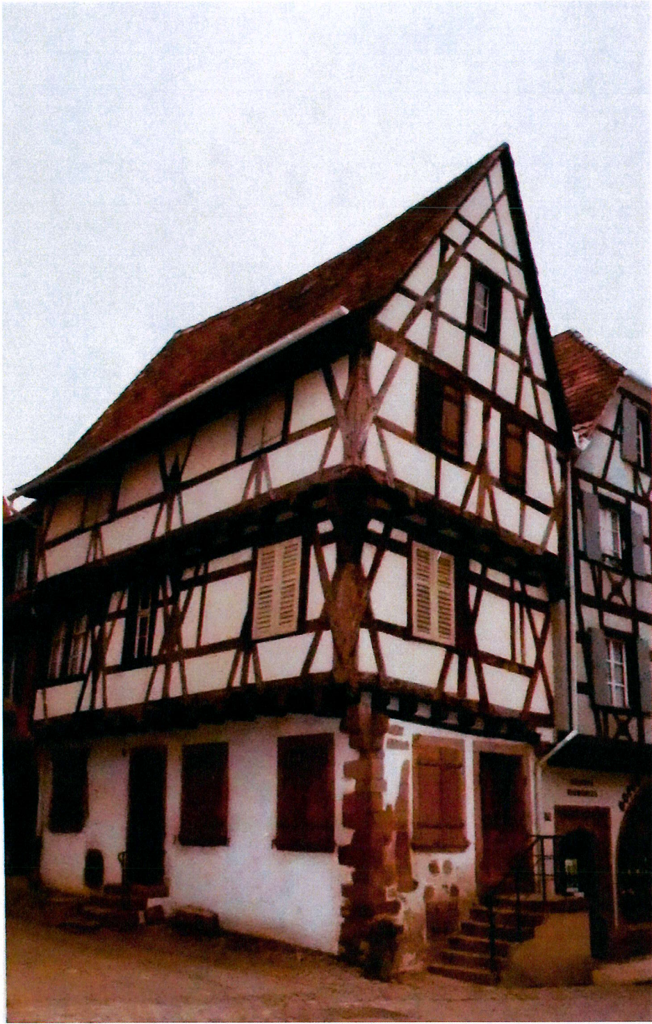
Maison du 1 rue des Trois-Eglises, vers 1480 [Source : MPP, D/1/68/34_3]
