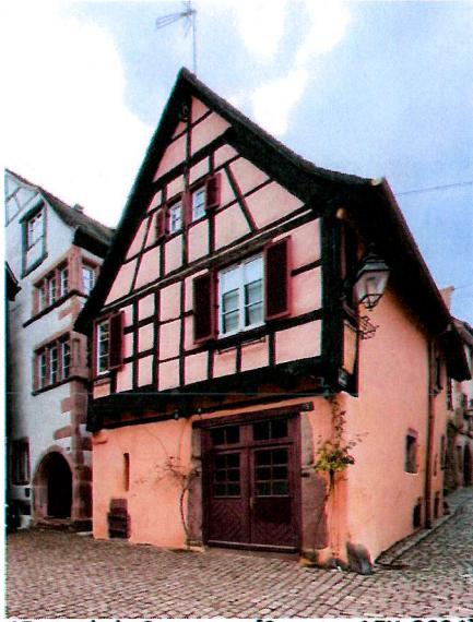
15 rue de la Couronne [Source : AFK, 2024]
