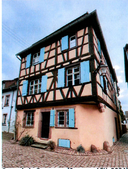
9 rue de la Couronne [Source : AFK, 2024]
