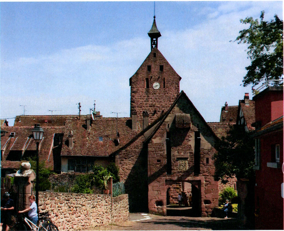
Le Dolder et son avant-porte, rue Général-de-Gaulle [Source : I&L, 2023]
