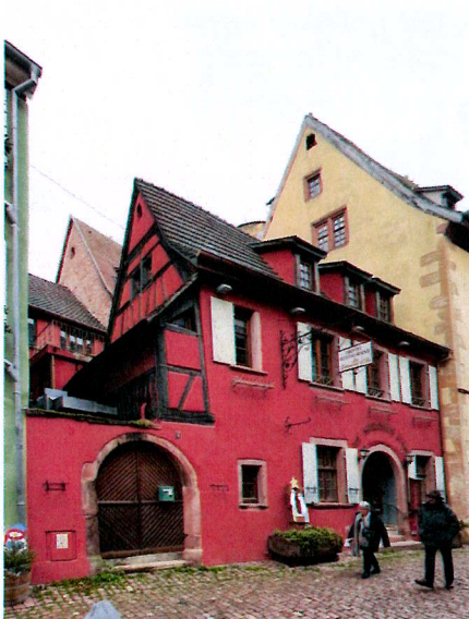
6 rue du Cerf [Source : AFK, 2024]
