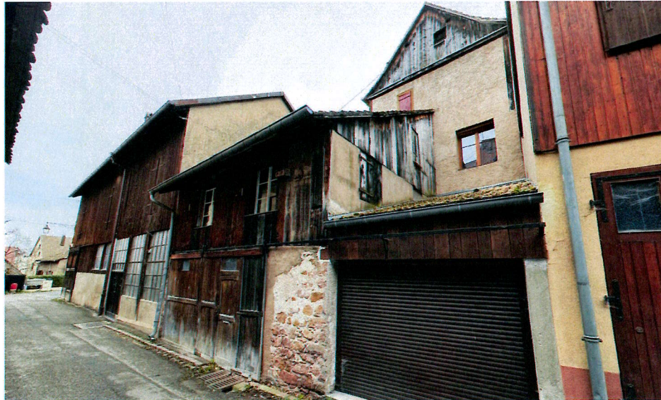
rue des Remparts [Source : AFK, 2024]
