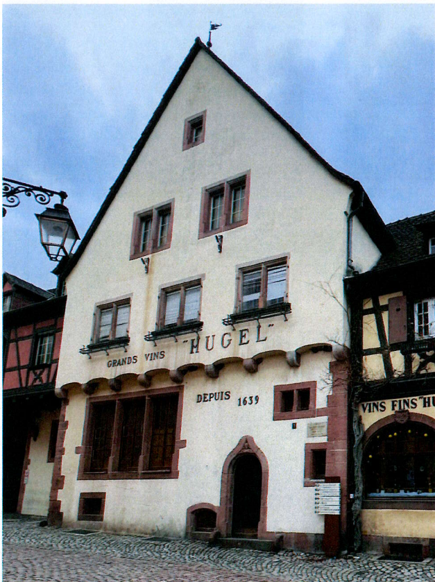
Façade en maçonnerie et grès des Vosges, rue de la Première-Armée [Source : AFK, 2024]
