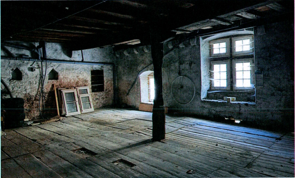
Planchers bois et murs en pierre limitant les ponts thermiques, 6 rue Saint-Nicolas [Source : AFK, 2024]
