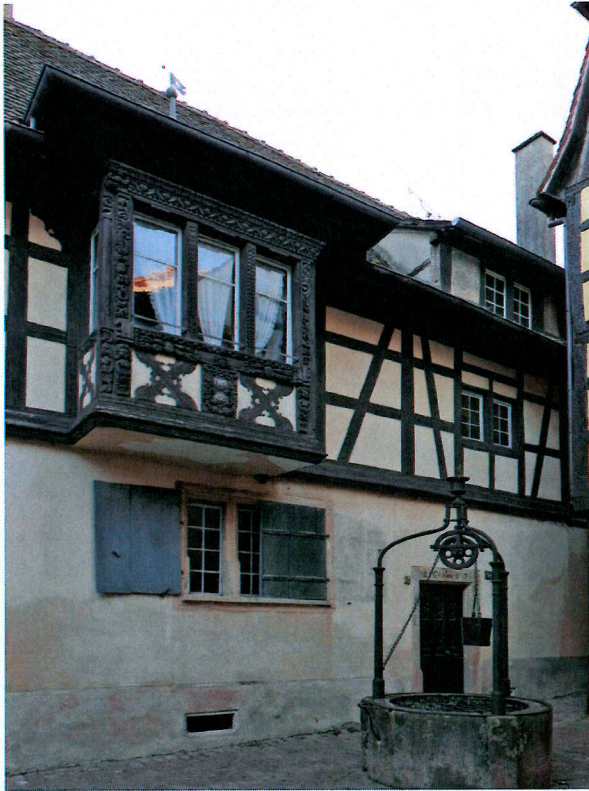
Oriel à deux niveaux, 18 rue de la Couronne [Source : LMDP, 2024]
