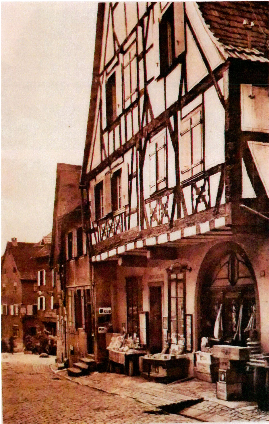
Maison à «l'Ours noir», première structure connue en Alsace d'une ossature dite «chevalet à jambe de force », réalisée vers 1435 [Source : MPP, D/1/68/33_33]
