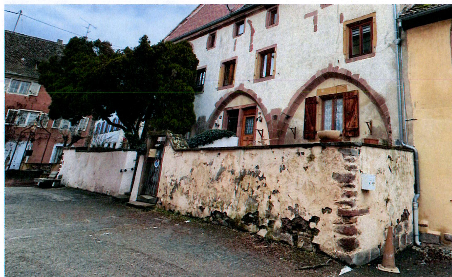
Mur de clôture, place des Trois-Eglises [Source : AFK, 2024]
