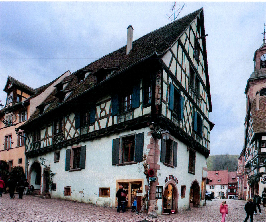
Ancienne maison vigneronne / du boulanger, 28 rue Général-de-Gaulle [Source : AFK, 2024]
