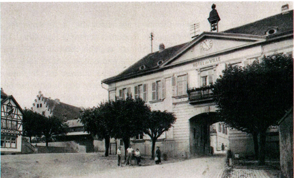
L'aménagement de la place à l'Est, de la ville aujourd'hui place Fernand Zeyer, et la façade de l'hôtel de la ville à la fin du XIX e siècle [Source : DRAC Grand Est, Pôle des patrimoines, Denkmalarchive DKM277B005_002]
