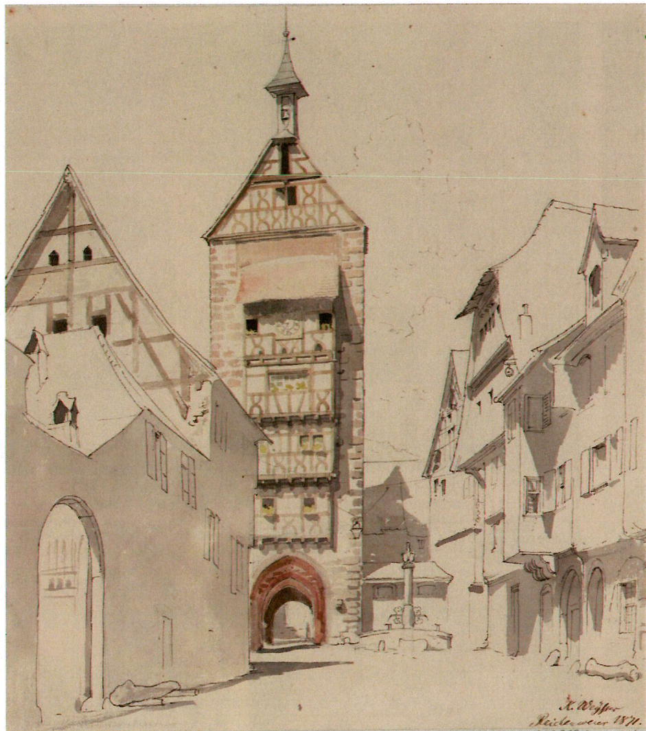
Vue du Dolder depuis le centre ancien, 1291 [Source : DRAC Grand Est, Pôle des patrimoines, Denkmalarhive , RAR_277_C001, signée et datée K. Weysser, 1871]. Sur la gauche est visible le portail d'entrée de l'ancienne cour dimière.
