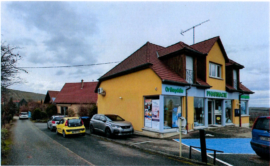
Route de Colmar [Source : AFK, 2024]
