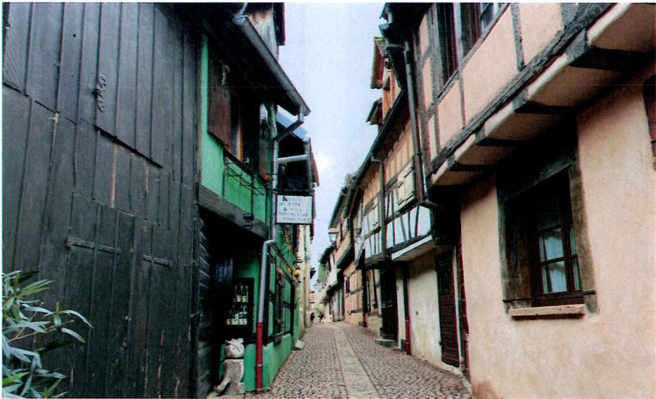
rue des Remparts [Source : AFK, 2024]
