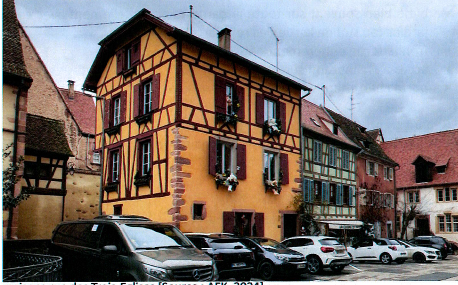
maisons rue des Trois-Eglises [Source : AFK, 2024]
