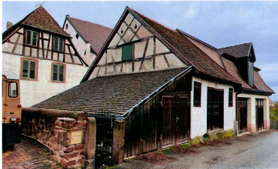
rue des Remparts [Source : AFK, 2024]
