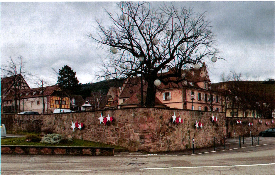
Vestiges du 2 nd rempart et du bastion sud-est, rue Méquillet [Source : AFK, 2024]
