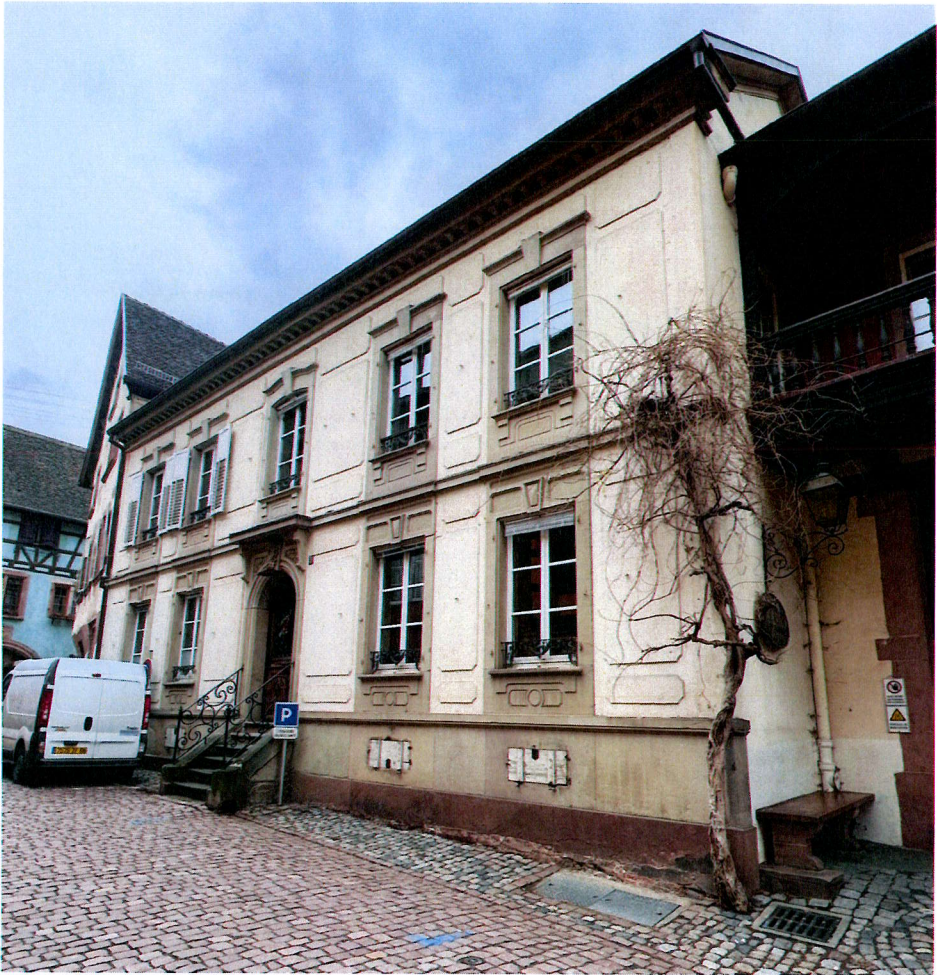
Bâtiment au 3 rue de la Première-Armée, construit en 1880 [Source : AFK, 2024]
