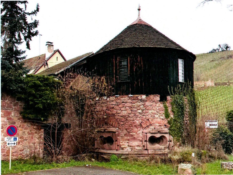
Tour dans l'angle nord-est de l'enceinte extérieure. Les canonnières portent le millésime de 1615 [Source : AFK, 2024]
