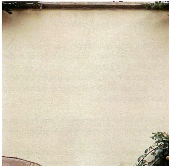
Enduit à la chaux [Source : AFK, 2024]
