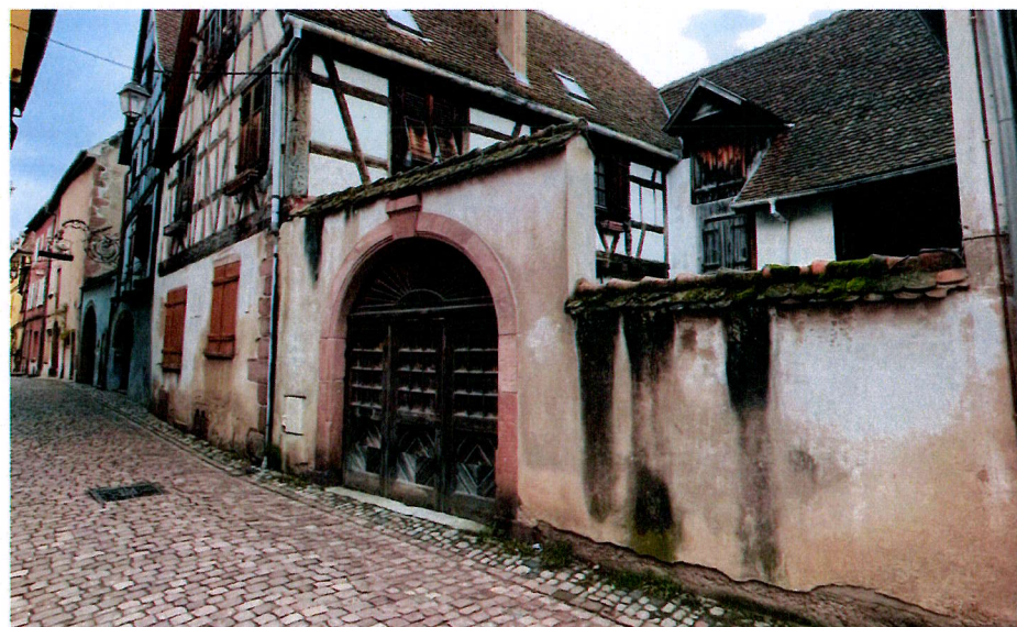
Mur de clôture de cour, rue de la Première-Armée [Source : AFK, 2024]
