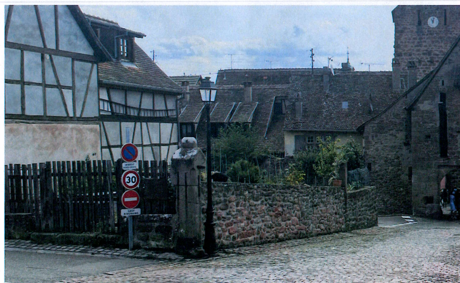
Clôture de jardin, rue du 5 Décembre [Source : Digitalepaysage, 2024]
