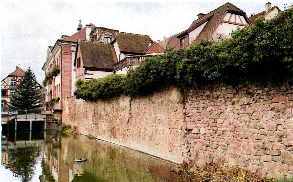
Vue de la portion nord-est de l'enceinte extérieure, vers 1480 [Source : AFK, 2024]
