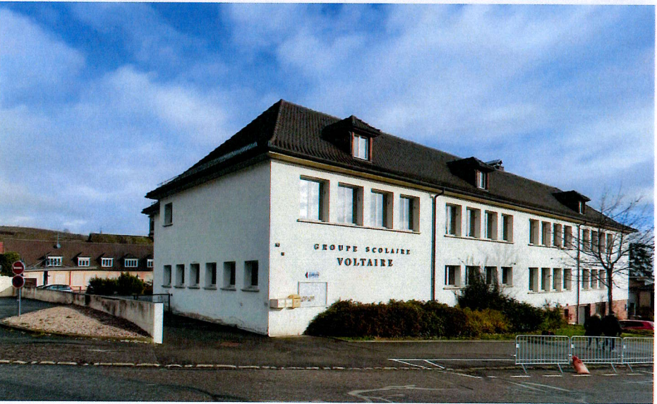
Groupe scolaire et bibliothèque municipale, avenue Méquillet [Source : AFK, 2024]
