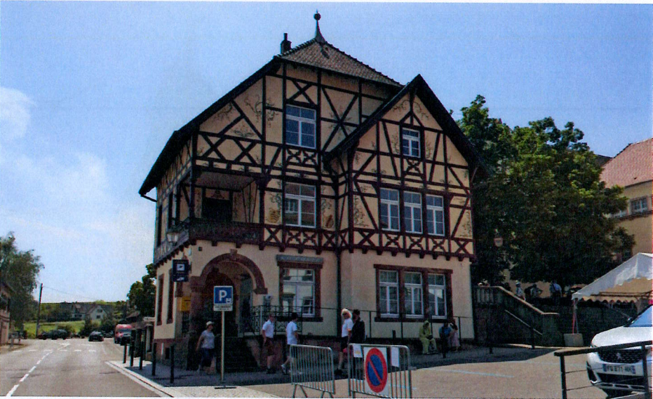
La Poste, avenue Méquillet [Source : Ici-et-Là 2023]
