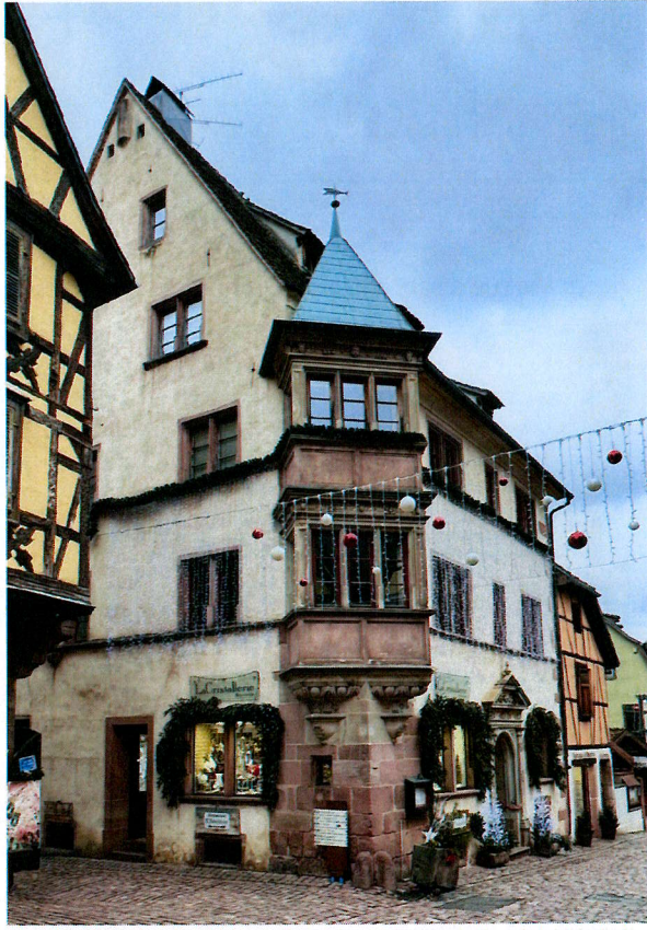
Oriel d'angle à deux niveaux, 12 rue du Général-de-Gaulle [Source : AFK, 2024]
