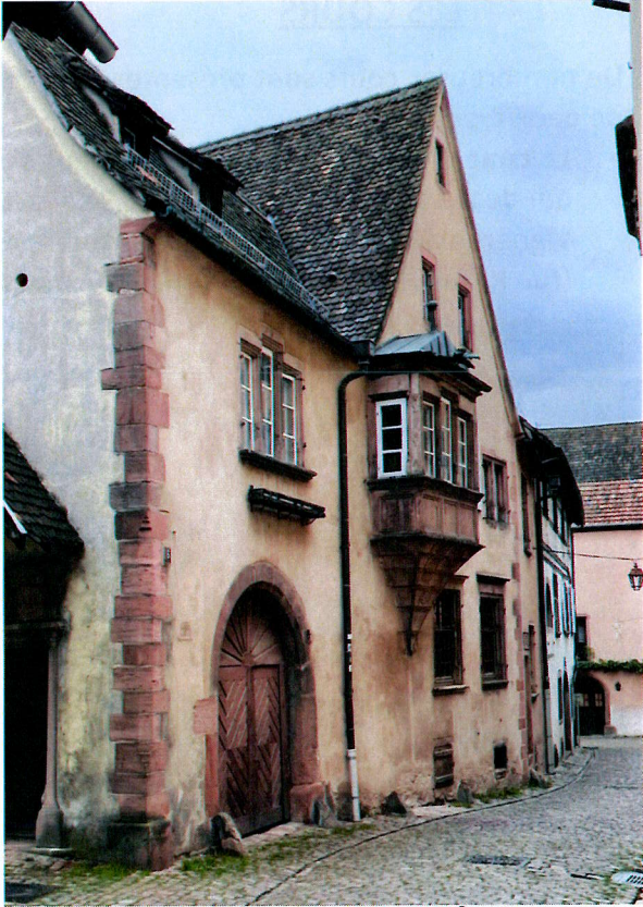
Oriel, 7 rue Latérale [Source : AFK, 2024]
