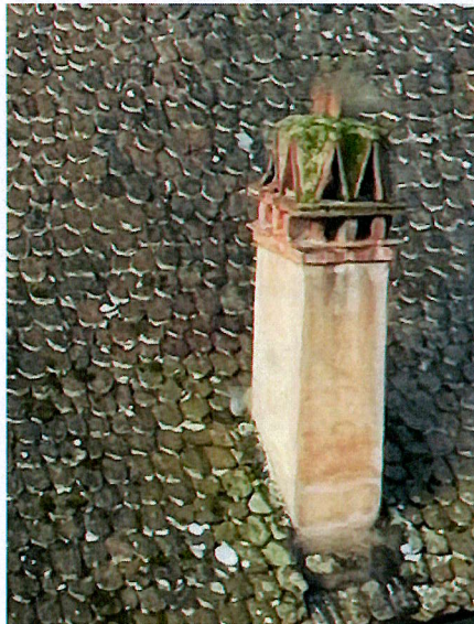
Tuiles plates Biberschwanz artisanales [Source : AFK, 2024]
