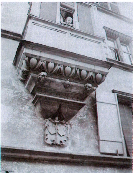
Appui de l'oriel de la maison Dissler [Source : DRAC G-E, Pôle des patrimoines, Denkmalarhive , DKM277B002_004, 1910]
