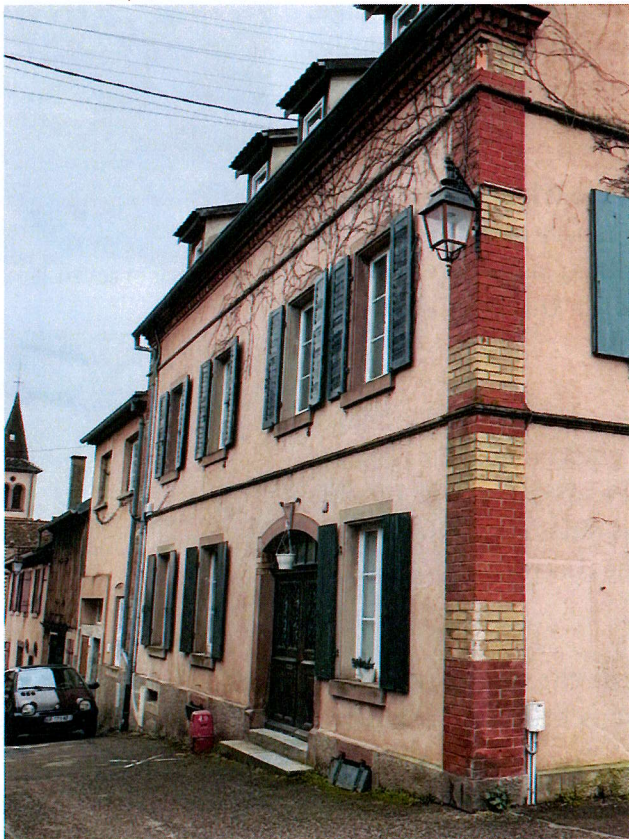
Façade en maçonnerie, grès allemand et briques, rue des Remparts [Source : AFK, 2024]
