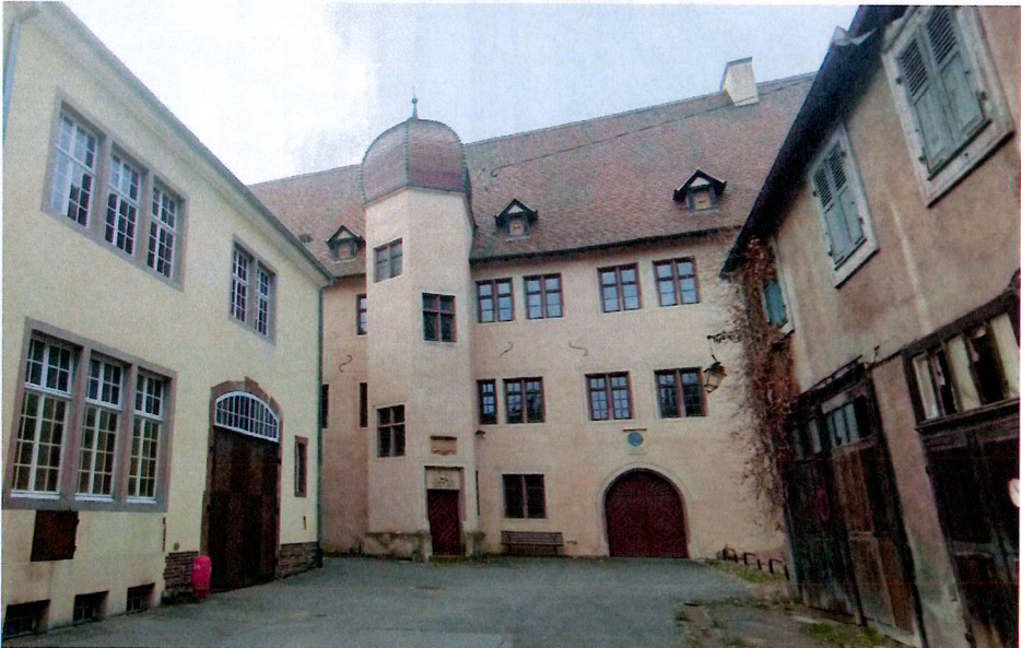
Élévation nord du château, 1540 [Source : LMDP, 2024]
