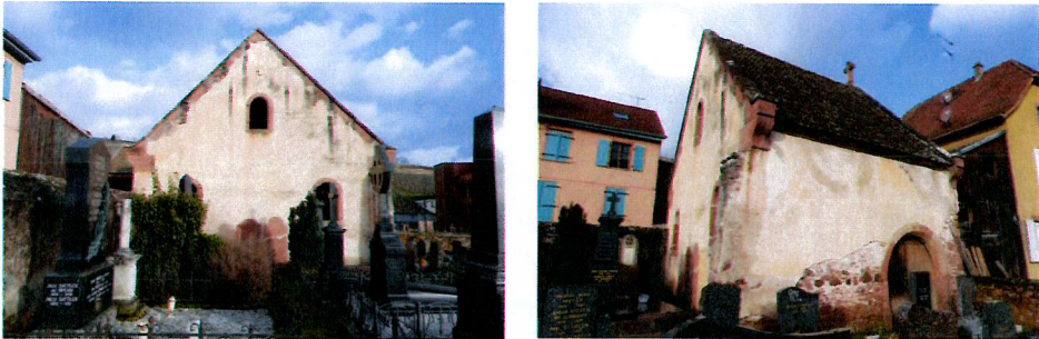
Chapelle du cimetière, reconstruite en 1752 avec des matériaux provenant du précédent bâtiment [Source : LMDP, 2024]
