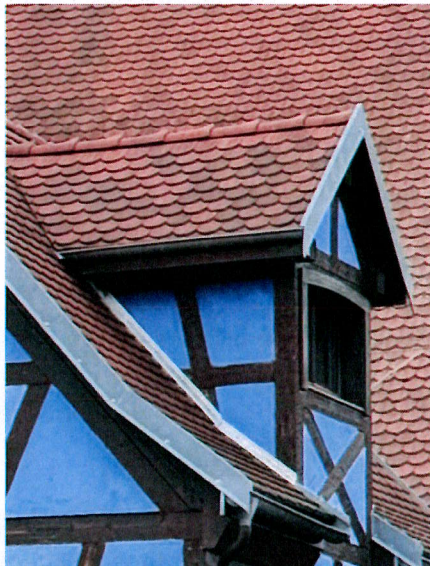
Tuiles plates Biberschwanz industrielles [Source : AFK, 2024]
