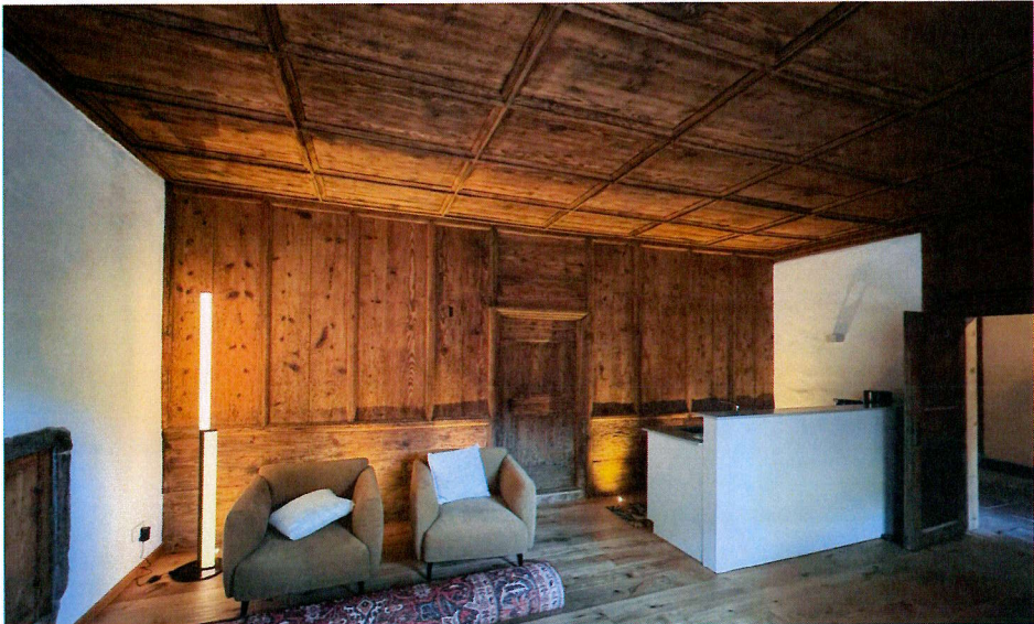
Parements bois à faible effusivité, en cloisonnement intérieur ou en placage contre les murs extérieurs - Séjour, 20 rue de la Couronne [Source : AFK, 2024]
