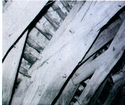
Détails de la charpente en berceau et de l'assemblage des arbalétriers et des aisseliers, 1344 [Source : MPP, E/81/68/31_11, ancienne chapelle de l'hôpital St-Erard, ph : J-P. Beck, 1983]
