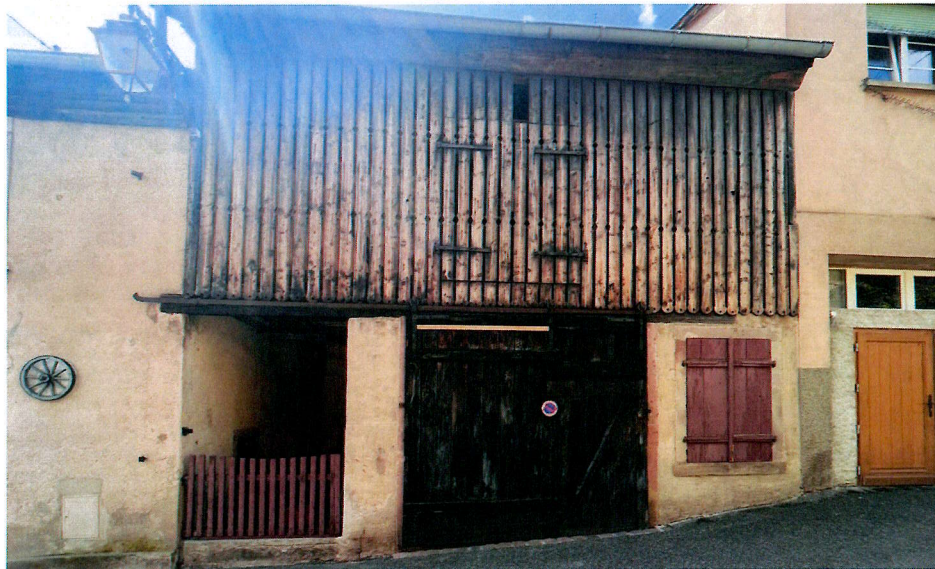
rue des Remparts [Source : AFK, 2024]
