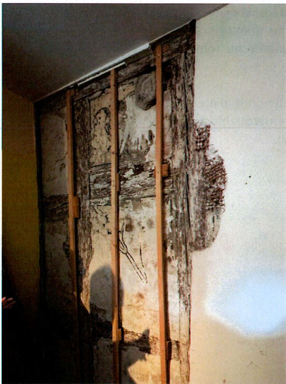
Décors peints en cours de mise au jour, 20 rue de la Couronne [Source : AFK, 2024]
