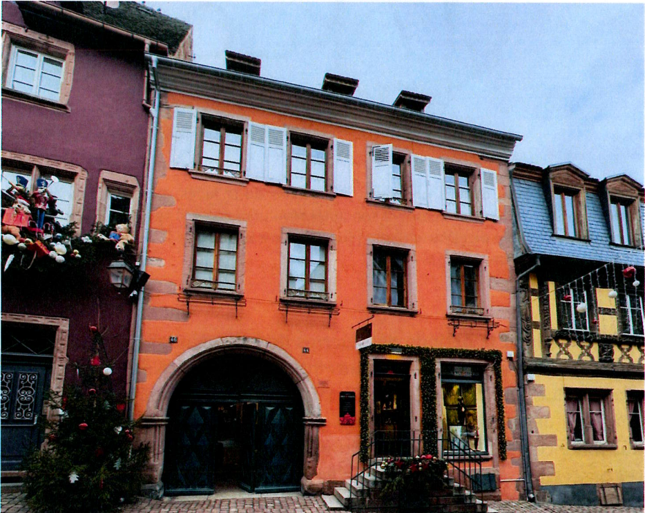
Maison au 44-46 rue du Générale-de-Gaulle, reconstruction en 1686 [Source : AFK, 2024]
