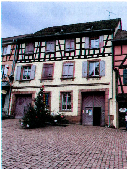
Toit 2 pans à gouttereau sur rue et coyau [Source : AFK, 2024]
