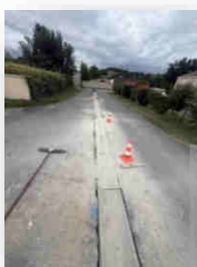
Fixation des caniveaux centraux descellés – Impasse des Lilas
