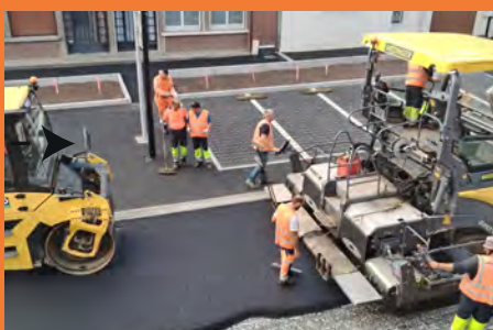
Pendant les travaux
