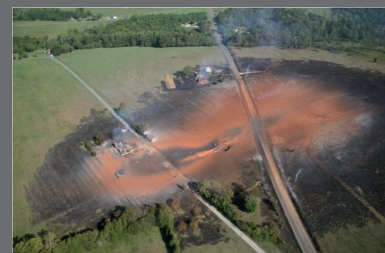
Conséquences d'une fuite sur une canalisation de transport, Appomatox (USA), 14 septembre 2008 (source pstrust.org).
