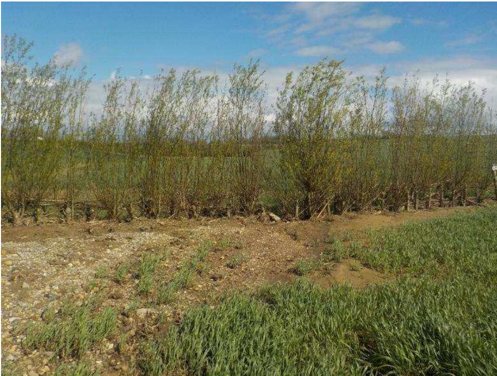
Photo fascine 1 : les fagots horizontaux de branches de saules n'existent plus
