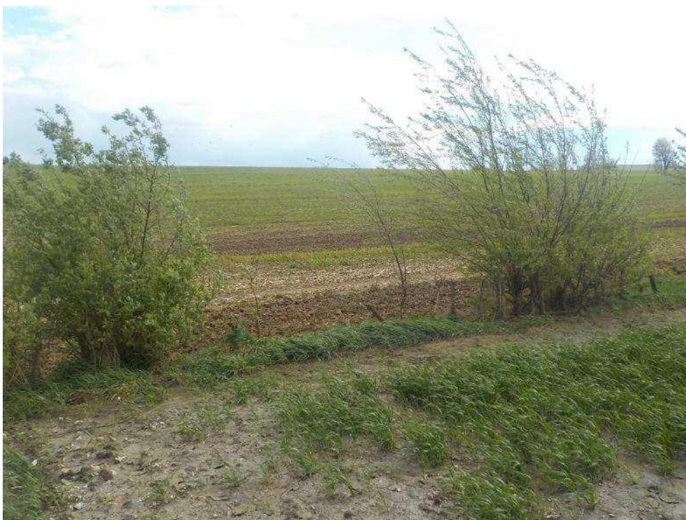
Photo fascine 3 : les fagots horizontaux de branches de saules n'existent plus
