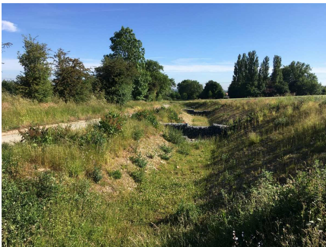
Fossé à redents
