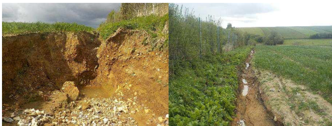
Photo 1a et 1b : Erosion le long du délaissé de l'autoroute A26 à l'amont de l'OTH
