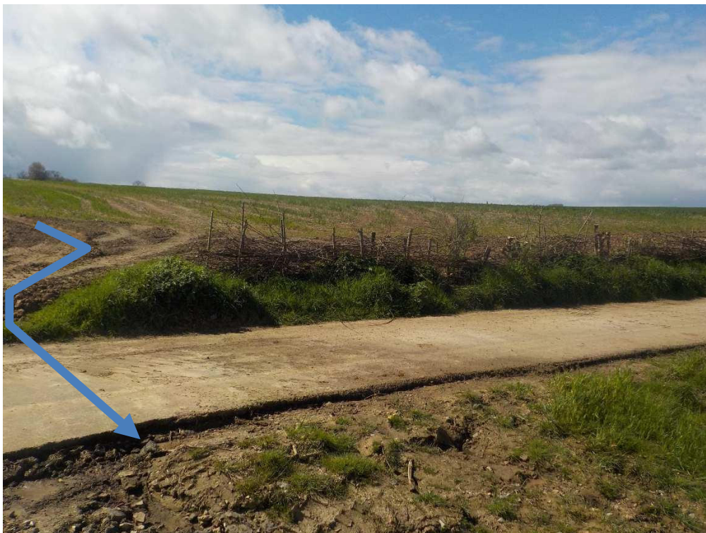
Photo fascine 4 : la fascine n'est pas implantée dans l'axe de ruissellement
