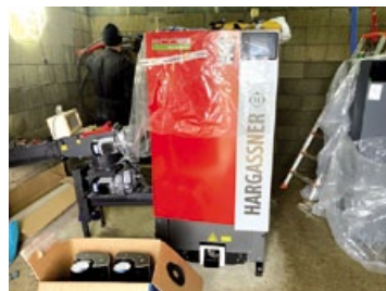
La chaudière bois et l'électrofiltre.
