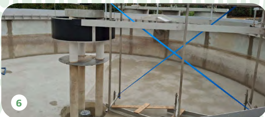
4 : Intérieur du bassin de décantation en cours de remplissage
