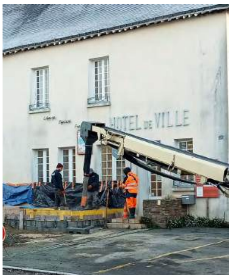
Coulage du béton pour la rampe d'accès PMR
