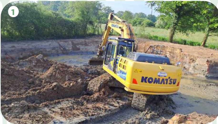
1 et 2 : Terrassement et forage des pieux
