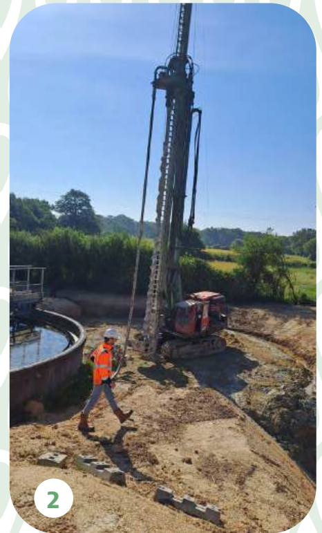
1 et 2 : Terrassement et forage des pieux
