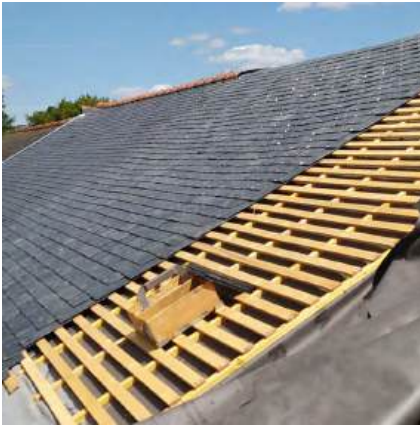
Réfection d'une partie de la toiture (classe de maternelle + salle des maîtres)
