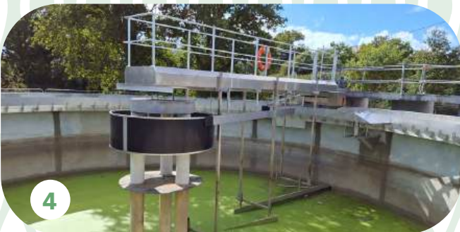
4 : Intérieur du bassin de décantation en cours de remplissage
