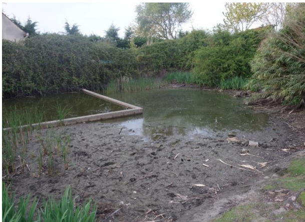
Vue sur le coffre bétonné (piège à faune aquatique), et accumulation de vase sur les bords sud de la mare
