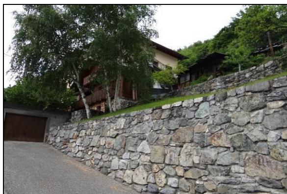
Photo 14 : Exemples de murs de soutènement en pierre
