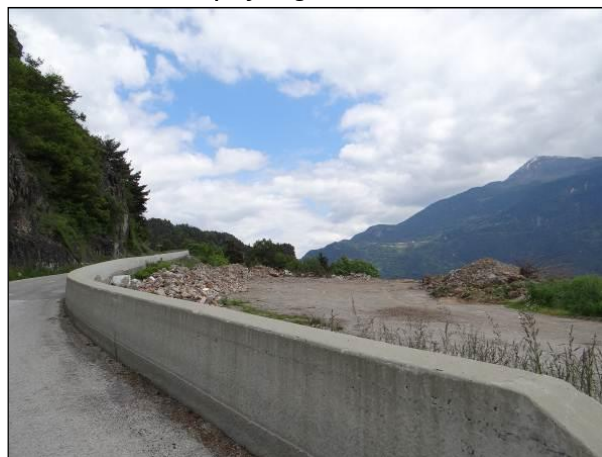
Photo 33 : Zone de stockage de matériaux
