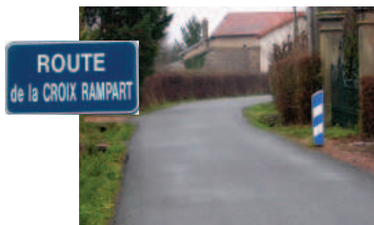
VC3: monocouche double gravillonnage bitume fluxé
