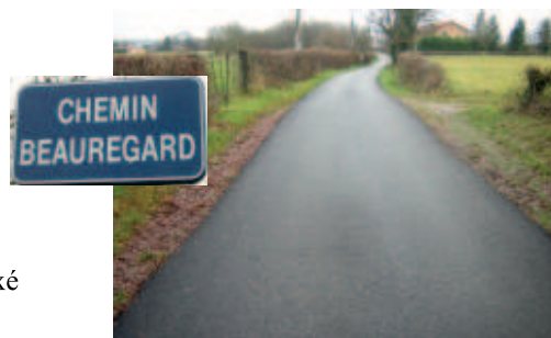
VC109: reprofilage et mise en œuvre d'un enrobé
